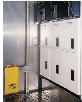
Surélévation des unités fonctionnelles 400 - 630 A sur socle 350 mm
