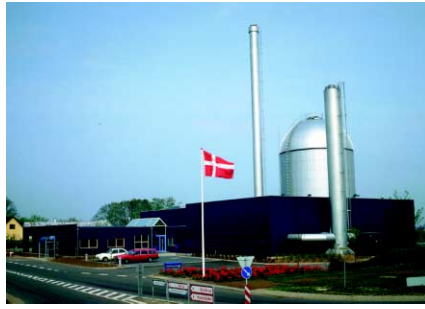
Centrales électriques, Moteur Diesel/gaz (construit par Wärtsilä)
